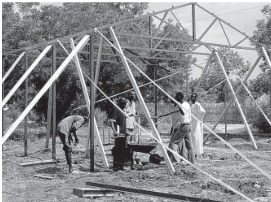
Alcuni operai durante la costruzione di una Chiesa.
